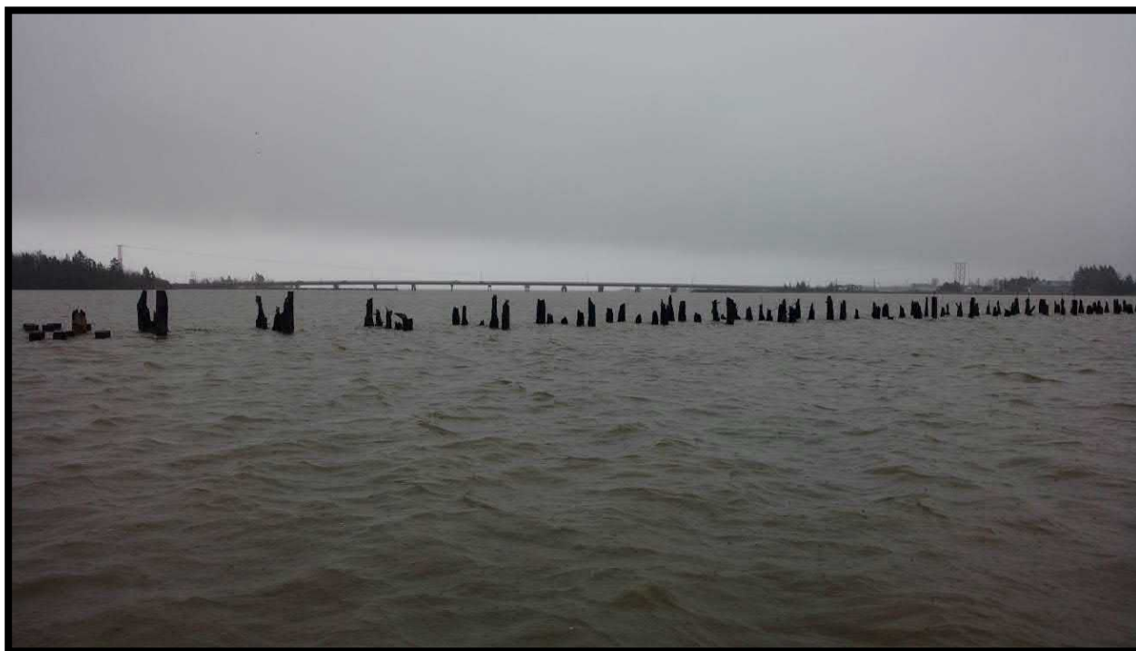
Photo no 4 : Pieux de bois créosoté calcinés (vue vers le sud, 6 décembre 2017)
