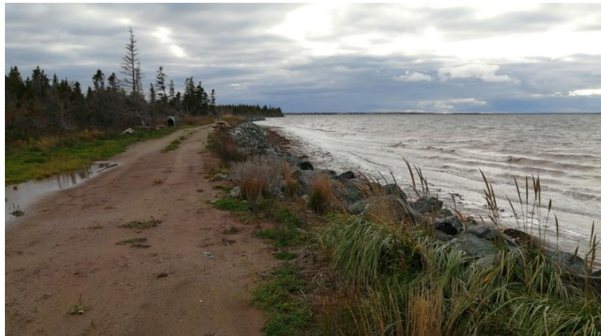
Photo 22 : Chemin le long de la côte vis-à-vis le lot 2015-1. L'énrochement, qui débute à la limite de propriété à l'est, se poursuit jusqu'à la limite ouest de la propriété.
