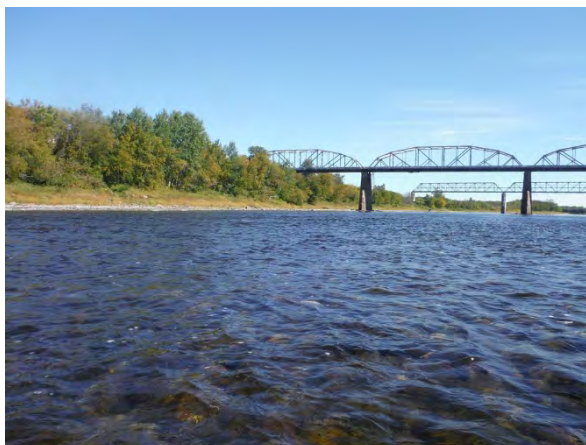
Photo 6 Habitat du poisson dans l'empreinte du projet, à environ 125 m en amont du pont existant
