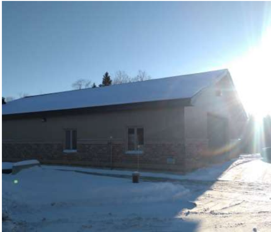
Photo 2 : Vue du puits no 1 (22 novembre 2018)
