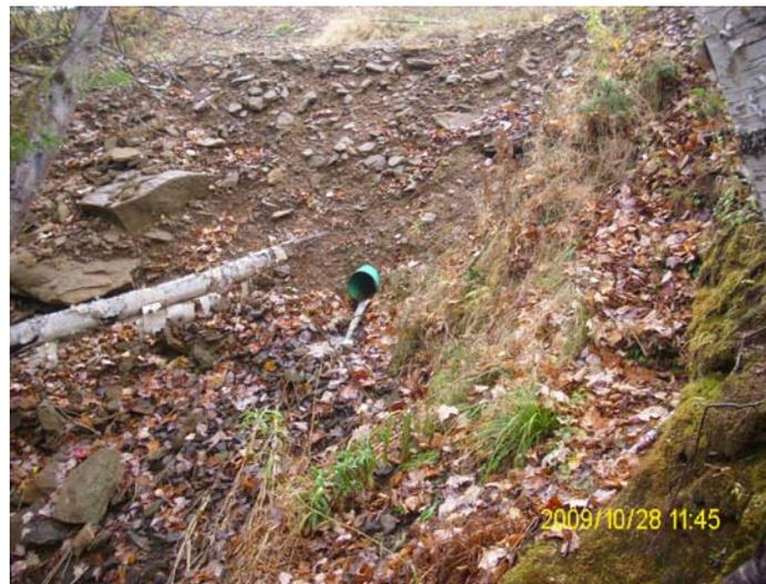
Figure 5: Décharge de l'eau traitée de la lagune
