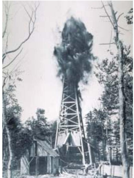
Figure 4 : Fracturation d'un puits du champ de Stoney Creek à l'aide de nitroglycérine, vers 1940.
