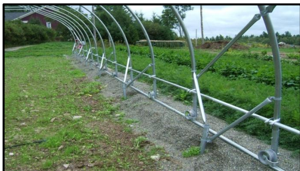
Structure sur rails: Rolling Thunder Moveable Greenhouse conçu par Rimol Greenhouse Systems, Inc (Gore Farm, St-Stephen, Nouveau-Brunswick)
