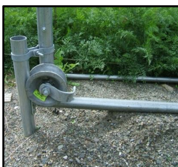
Structure sur rails: Rolling Thunder Moveable Greenhouse conçu par Rimol Greenhouse Systems, Inc (Gore Farm, St-Stephen, Nouveau-Brunswick)
