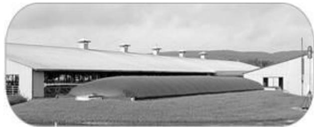
Fig 5. Digesteur anaérobie à écoulement piston
