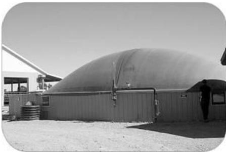
Fig 4. Digesteur anaérobie infiniment mélangé
